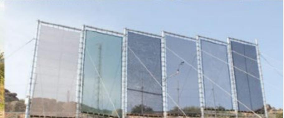
Opérant dans le sud marocain, le projet de l'ONG Dar SI Hmad est mené par un groupe de femmes qui ont conçu et installé un filet dans la région de Sidi Ifni, visant à capter le brouillard et à le transformer en eau potable pour les habitants de la région (74).
